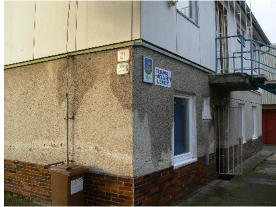
Obr. 8 Voda pretiekla aj na vonkajšiu fasádu budovy
