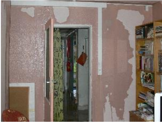
Obr. 7 Kompletne premočené steny
