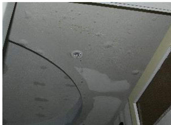
Obr. 2 Voda sa dostala do elektrických rozvodov
