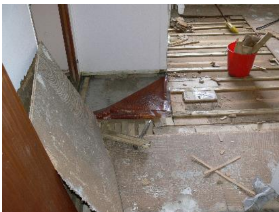
Obr. 5 Zničené podlahy na 1. poschodí
