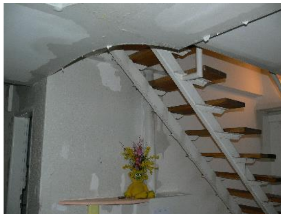
Obr. 6 Sadrokartónové stropy a obloženia boli úplne zničené
